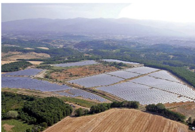
l'impianto fotovoltaico del Comune di Cavriglia
